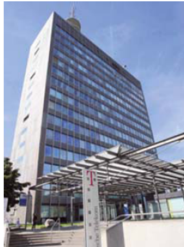
Erinnerung an alte Zeiten: Das Hochhaus in der Moltkestraße in Petershausen.
