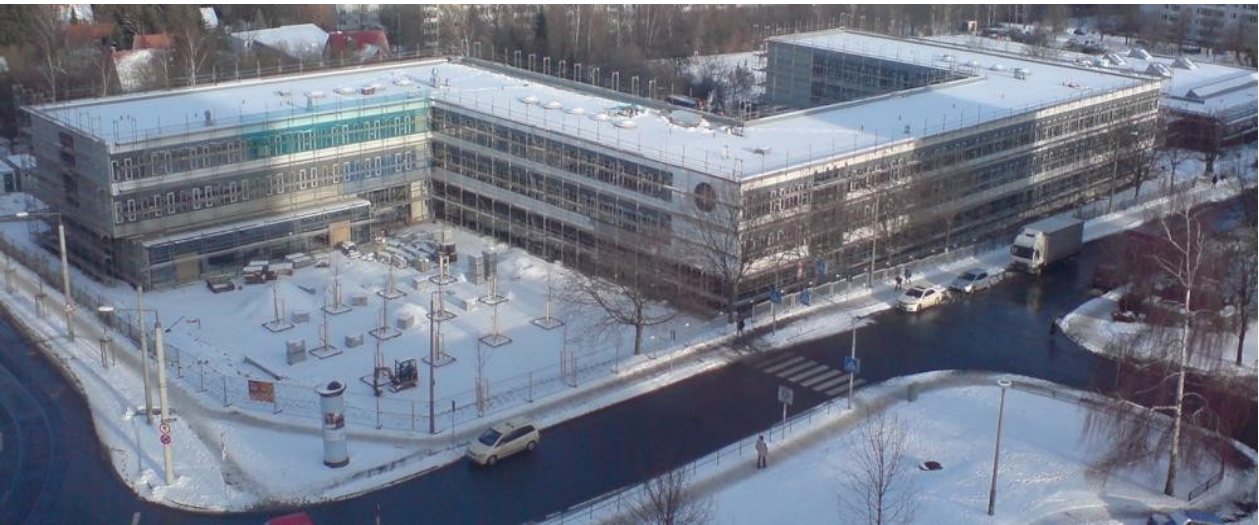
Bild oben: Neubau des Vitzthum-Gymnasiums in Zschernitz
