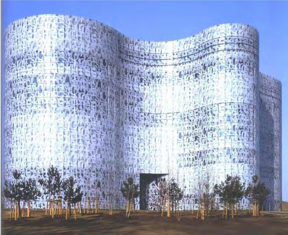
**Abb. 16:** Die geschwungene Glasfassade des IKMZ lässt erahnen, wie unterschiedlich die Raumsituationen im Inneren sind. Sie ist mit einem Ornament aus Schriftzügen rasterartig bedruckt. (© Duccio Malagamba)
